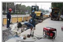
应急抢修施工
