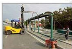
站台 市政施工
