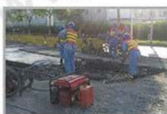
道路养护施工
