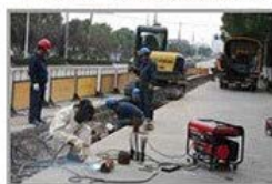
应急抢修施工
