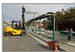
站台 市政施工
