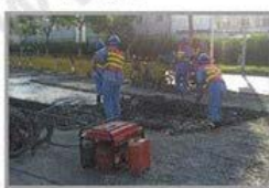
道路养护施工
